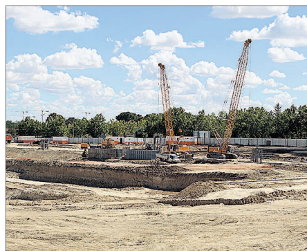
Un terreno en construcción en Madrid. PABLO MONGE
